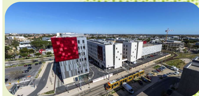
La clinique St Roch est raccordée au réseau de chaleur
